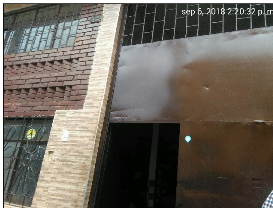
Foto No. 1 Fachada del establecimiento teñido
